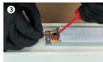
3 Raccorder le câble d'alimentation et le connecteur LED et régler l'intensité lumineuse.
