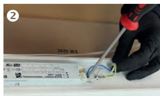
2 Débrancher les lignes d'alimentation et les câbles et démonter le ballast existant.
